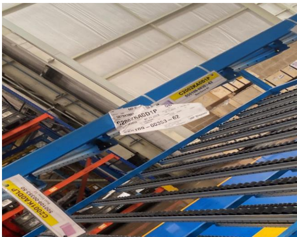
Ilustración 4. 14 Identificación de Racks
